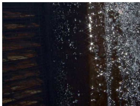
焙乾室の壁に付着したタール
